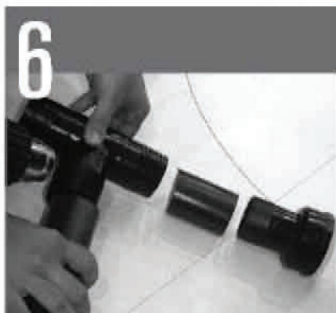
En los 4 extremos colocar 1 caño de 10.5 cm, y una pieza enchufe-rosca hembra de 2 pulgadas de polietileno.
