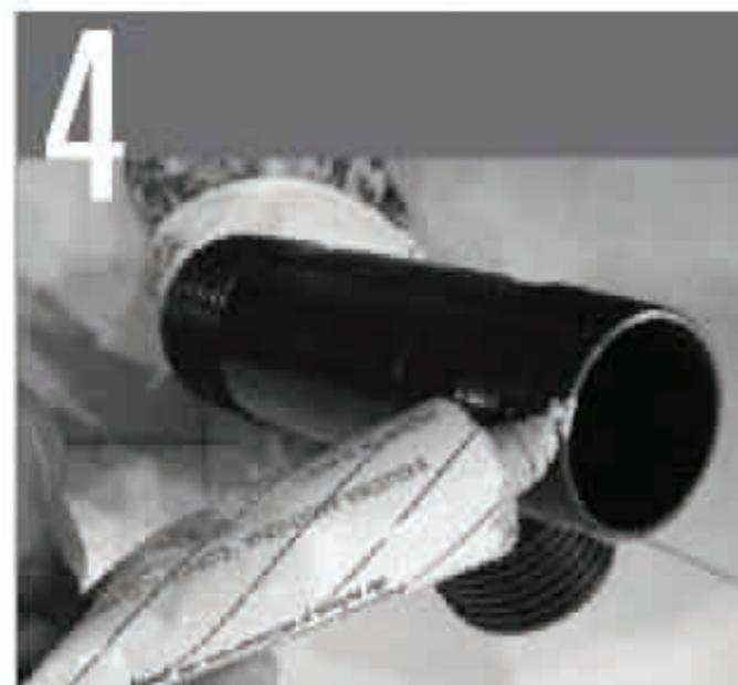
Para asegurar una buena unión entre piezas "T" y caños, se debe colocar sellador verde en los extremos de cada "T" y utilizar pistola de calor o agua caliente para ablandar y enchufar correctamente los extremos de cada caño.
