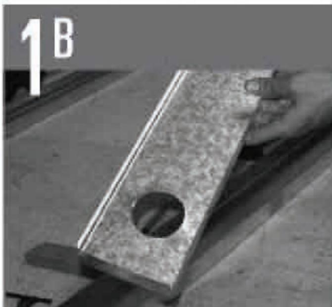
**Método 1:** hacer un agujero de diámetro mayor con una sierra para cortar metal y con la misma calar la chapa respetando el diámetro de 7.5 cm.
