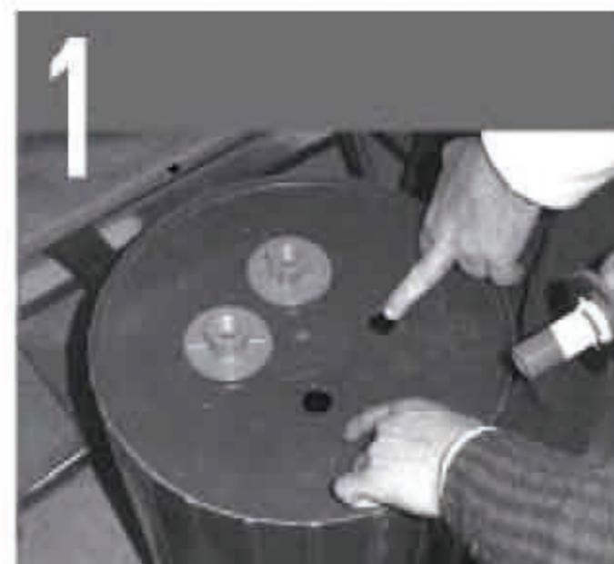
Realizar 4 agujeros en cruz (según ejes perpendiculares), ubicados a la misma distancia del centro de la base de los dos tanques.
