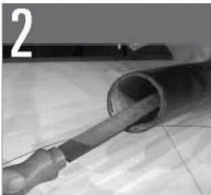
Lijar los bordes interiores cortados de las piezas para facilitar las conexiones a presión.
