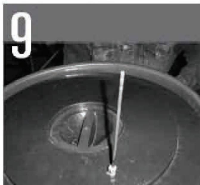
Realizar en las tapas de los tanques un "venteo" (Ruptor de vacío) mediante un pequeño orificio y colocar un caño de cobre u otro material de 1/8" o 1/4" de sección.
