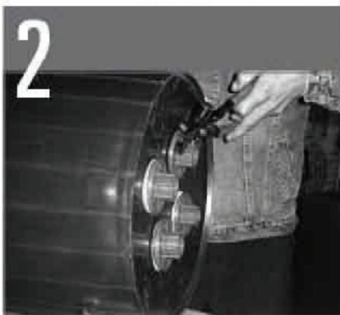
Colocar en el tanque más chico las cuatro salidas de fondo de tanque.
