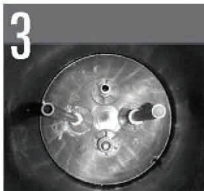
En el interior del tanque más chico, colocar un niple hembra-hembra en salida de fondo de tanque de 3/4" y otro en la de 1/2".
